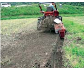
明渠の設置で排水対策を徹底
