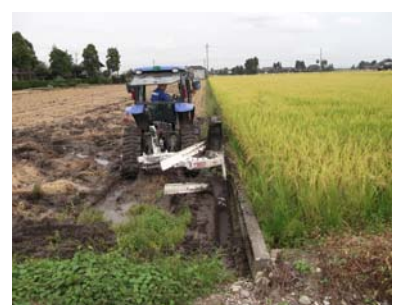
写真5 排水対策の実施
