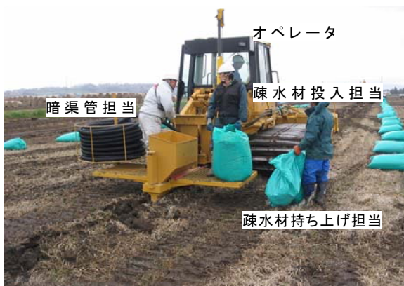
写真2 ベスト・ドレーンによる暗渠施工
