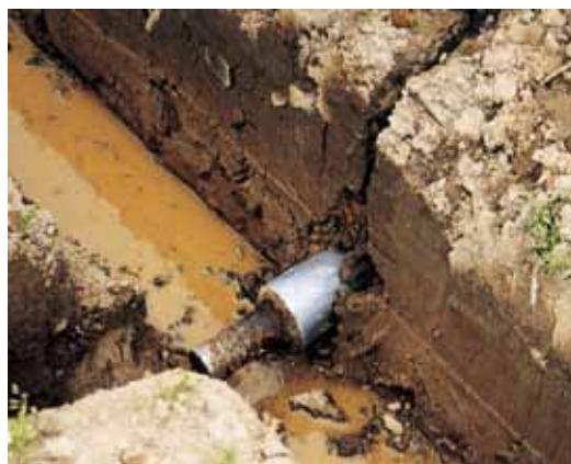
サブソイラーによる弾丸暗渠施工（左）と装着したドレーナーを明渠から貫通させ弾丸暗渠を形成（右）
