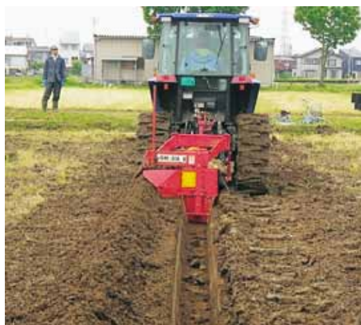
溝掘機による周囲明渠施工
