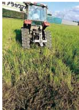
弾丸暗渠の施工
