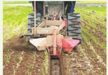
○ 溝掘機による明きよ施工（麦作付前） －水稻の排水溝跡を作溝－
