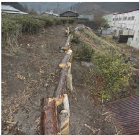
《転落危険箇所対策》 柵を設置
