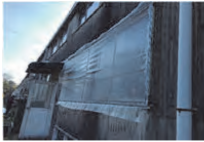
開ける窓への網戸の設置
