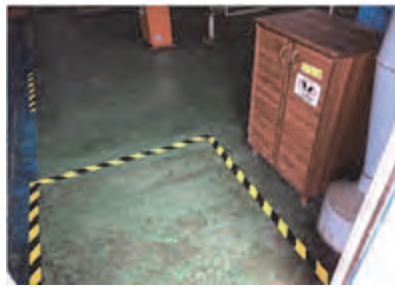
作業員出入口のゾーニング
