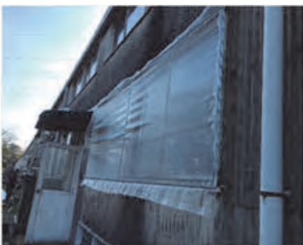
開ける窓への網戸の設置
