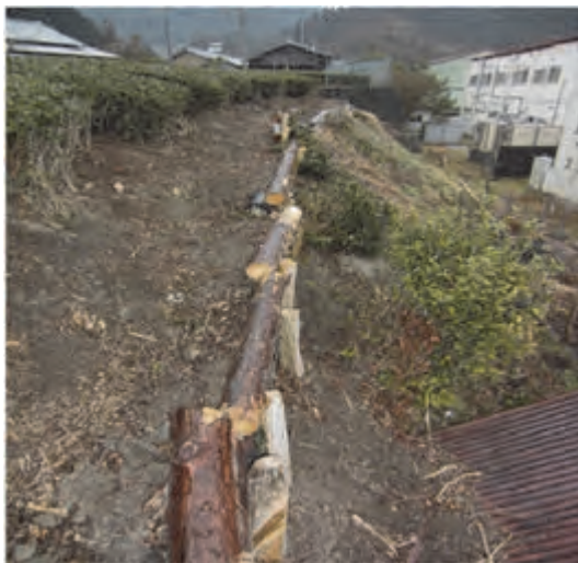
《転落危険個所対策》 柵を設置
