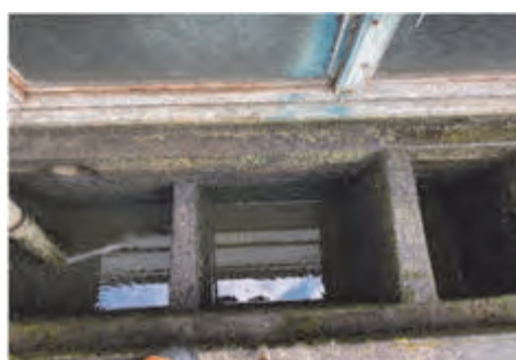
工場からの排水枡（前）→ 掃除後の排水枡（後）、マニュアルに掃除頻度を規定
