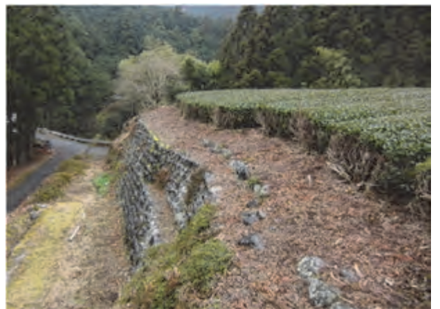
抜根により石垣からの余裕を持たせた
