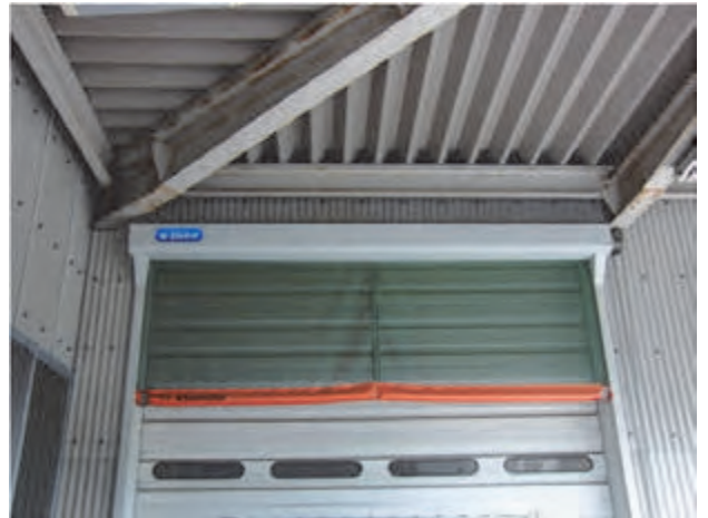
害虫等の侵入防止の為にネット・ネットシャッター設置
